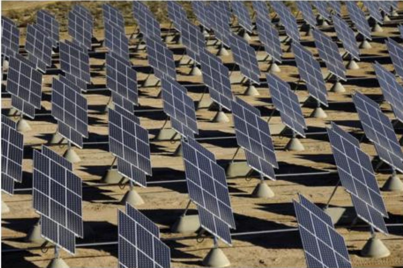
Nellis AFB Solar Project (courtesy SunPower Corp.)
